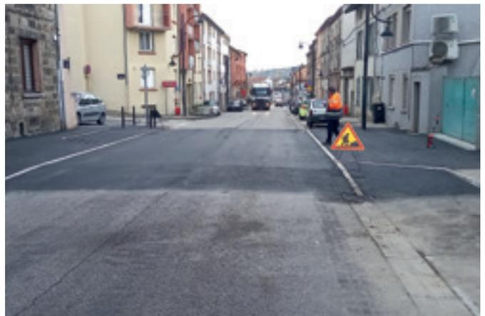
Plateau traversant terminé. La signalisation se fera après le ressuage du bitume.
