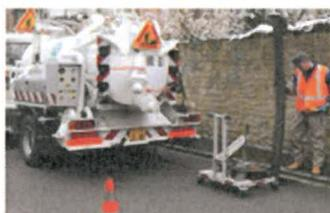
Le curage curatif des réseaux d'assainissement est réalisé afin de rétablir l'écoulement des effluents qui sont stoppés par des dépôts de matériau (terre, sable, cailloux), des objets (ballon, ...) en libérant le passage réduit de la section d'écoulement.
