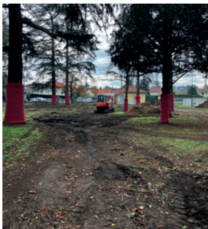
Les beaux spécimens d'arbres sains sont conservés et protégés pendant le chantier
