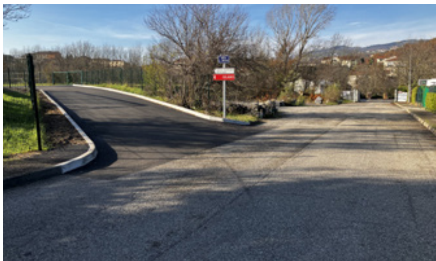
Enfin une véritable voirie à l'intersection avec la rue de l'Allée de l'Industrie"
