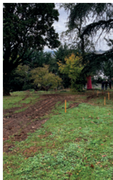
Le piquetage des allées reconditionnées vient d'être validé
