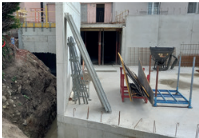
Vue sur l'entrée de la future traboule qui reliera le restaurant et la médiathèque.
