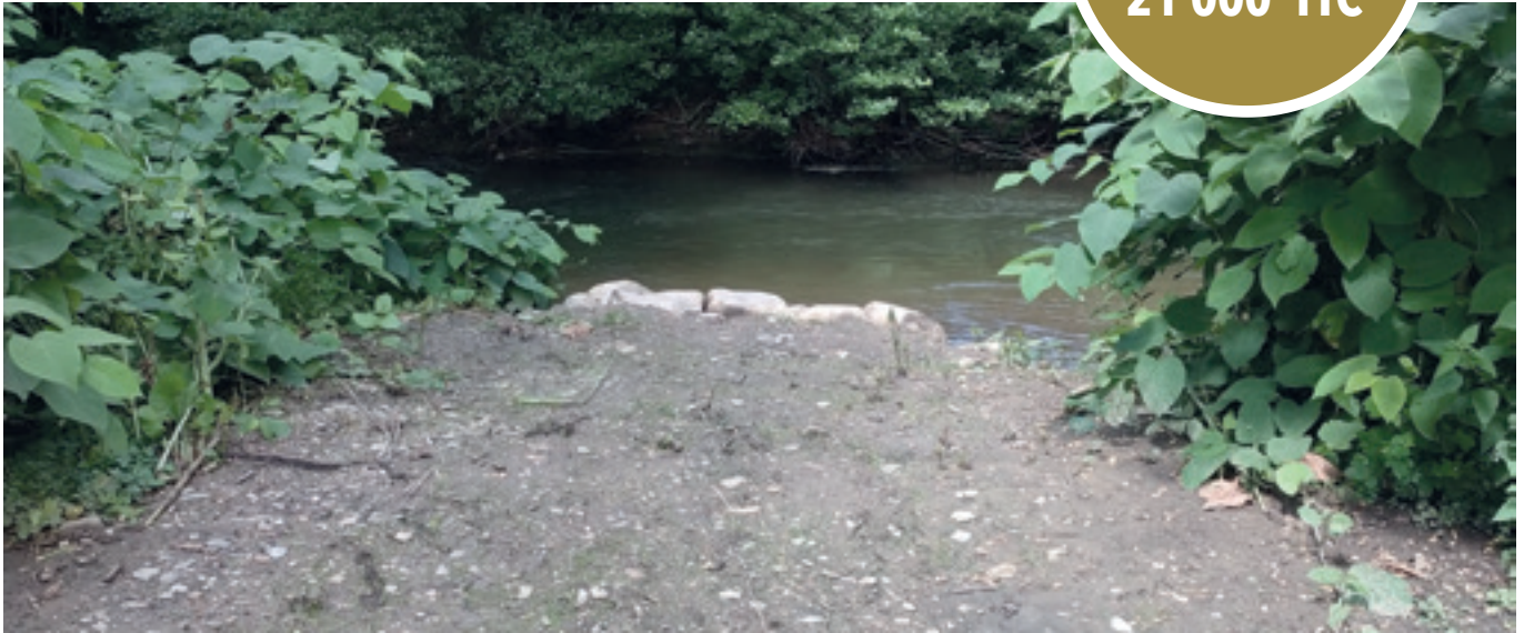
Les travaux finis au bord de la rivière
