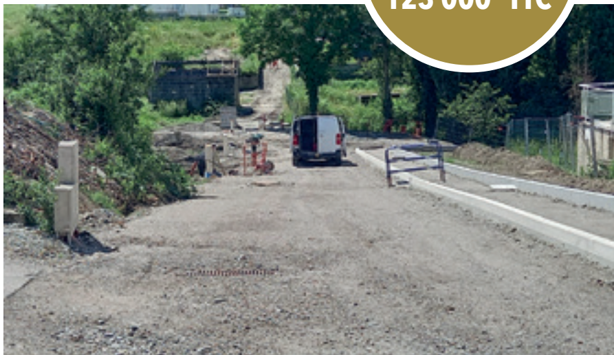
Vue du chantier en cours
