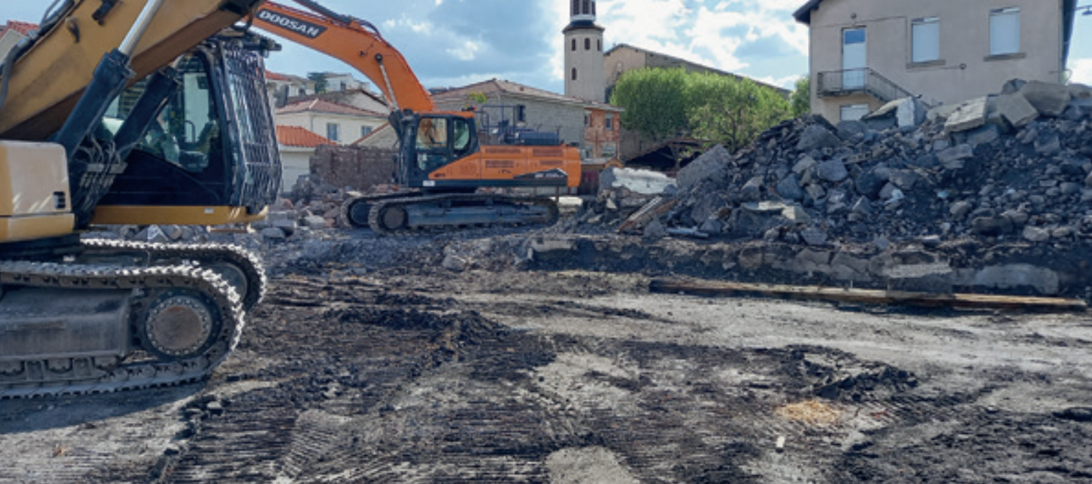
Travaux de déconstruction et de triage des matériaux
