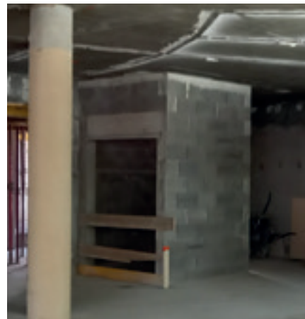
Emplacement du futur ascenseur
