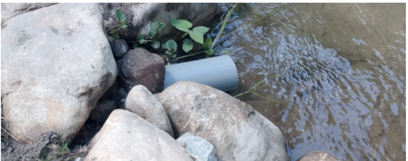
Vue de l'arrivée de la déviation au bord du Dorlay
