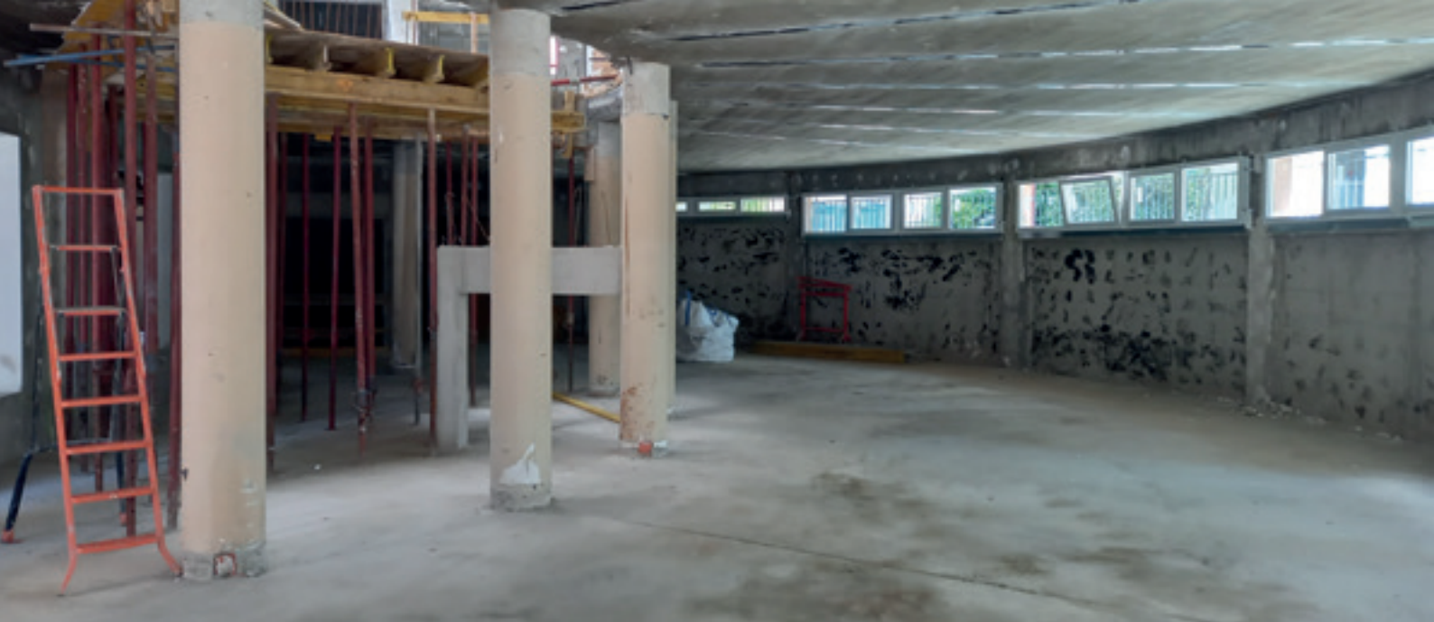
La trémie du futur escalier de liaison des 2 niveaux réalisée
