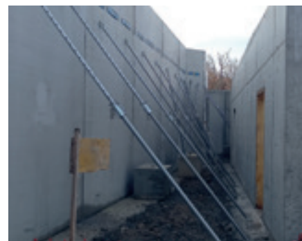
Maintien des murs préfabriqués avant coulage du béton entre les 2 parois.
