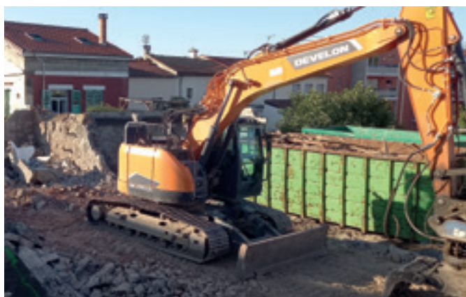
Après les premiers coups de pelleuse
