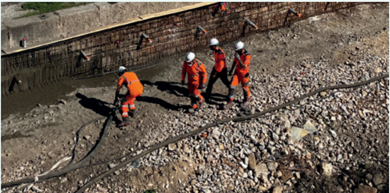
Renforcement des murs par projection de béton.
