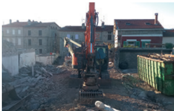
Triage des matériaux en cours
