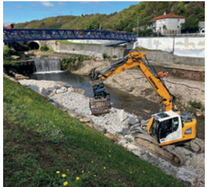
Le bloc de roche sera habilement bâti par le pelleteur.
