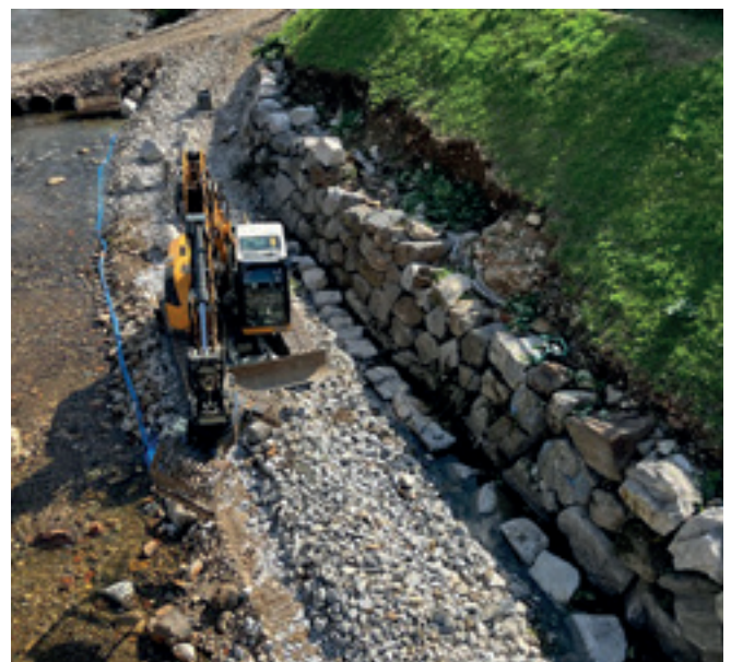
Vue de l'enrochement terminé
