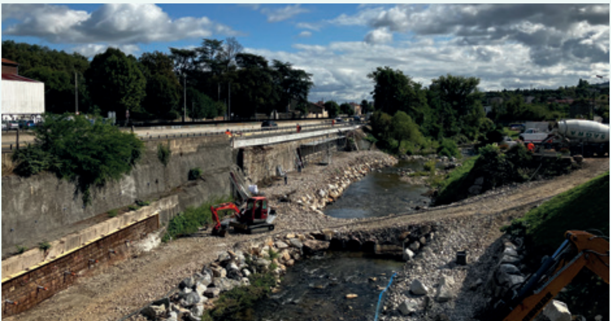
Vue du chantier
