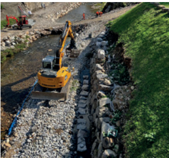
Vue de l'enrochement en cours de montage
