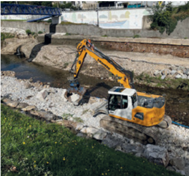
Chaque bloc de 500 kg est trié par le godet de la pelleuse
