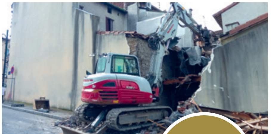
Démolition en cours
