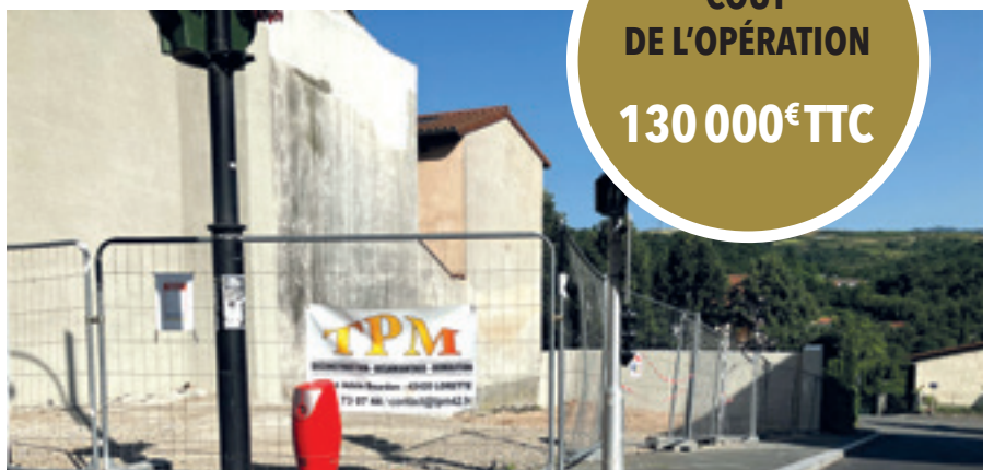
Après la démolition
