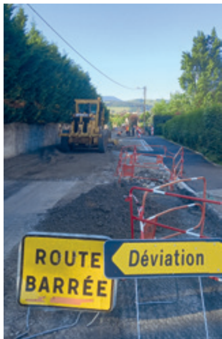
Photos pendant les travaux
